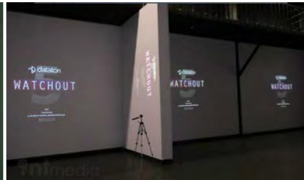
INTMEDIA выполнила техническую часть проекта. Наши инженеры спроектировали, выполнили инсталляцию и настройку автоматизированного программно-аппаратного комплекса. Проекционные и звуковые системы комплекса объединяет группа серверов на базе Dataton WATCHOUT. С помощью инструментов WATCHOUT выполнена шивка панорамных изображений.
