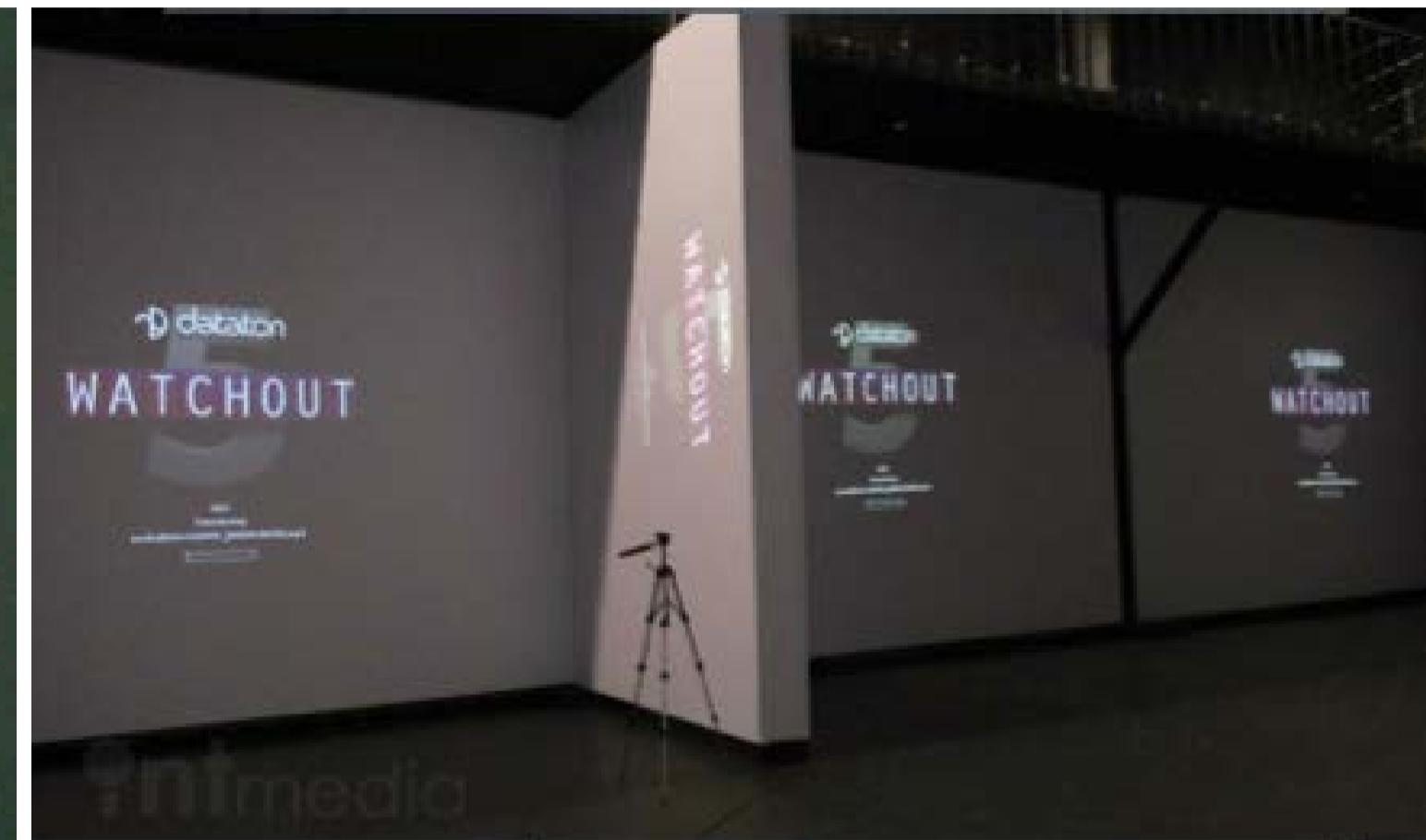
INTMEDIA выполнила техническую часть проекта. Наши инженеры спроектировали, выполнили инсталляцию и настройку автоматизированного программно-аппаратного комплекса. Проекционные и звуковые системы комплекса объединяет группа серверов на базе Dataton WATCHOUT. С помощью инструментов WATCHOUT выполнена сшивка панорамных изображений.
